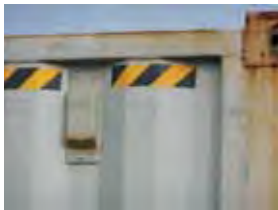
Verklebte Lüftungsschlitze
